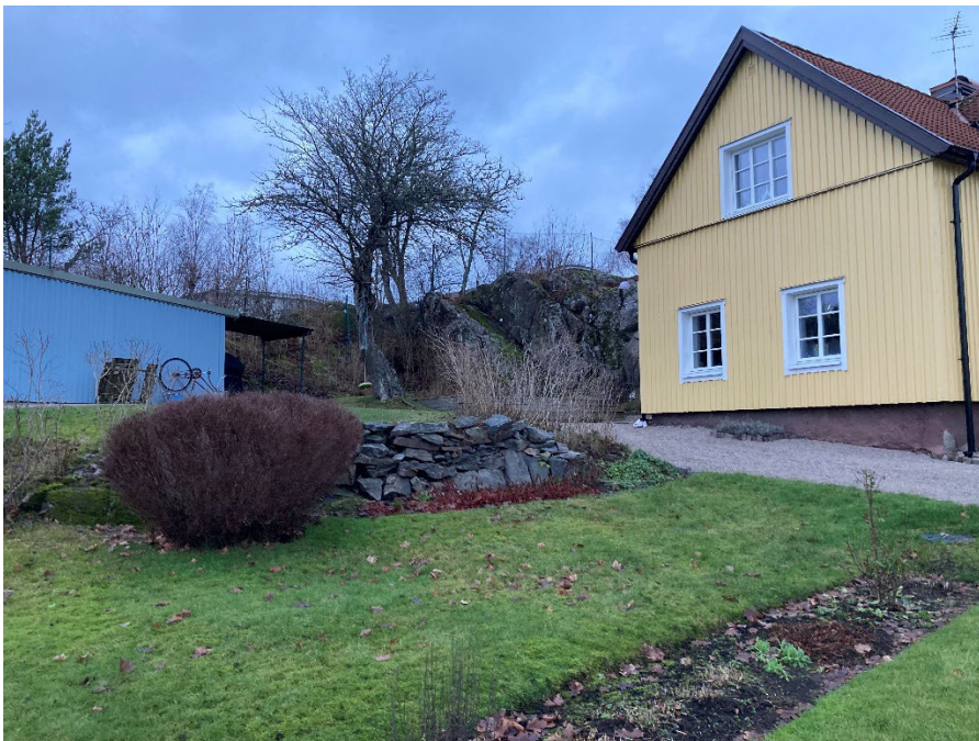
Det större bostadshuset ligger indraget från gatan.
