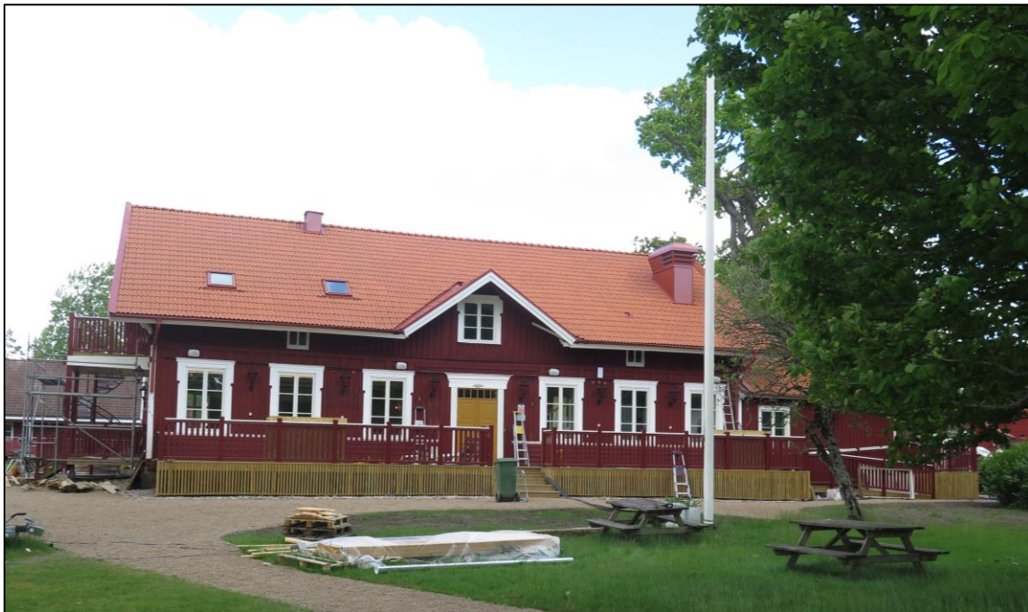
Nuvarande utseende. Foto vid slutsamrådet av om- och tillbyggnaden 2025-05-26 av Lars Bergström.
