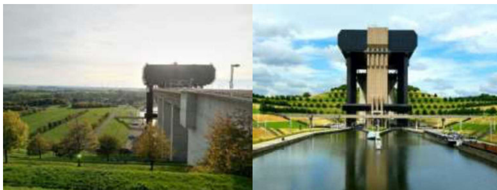
Figur 8. Bilder från Strépy-Thieu, Belgien. (Foto: Trafikverket)
