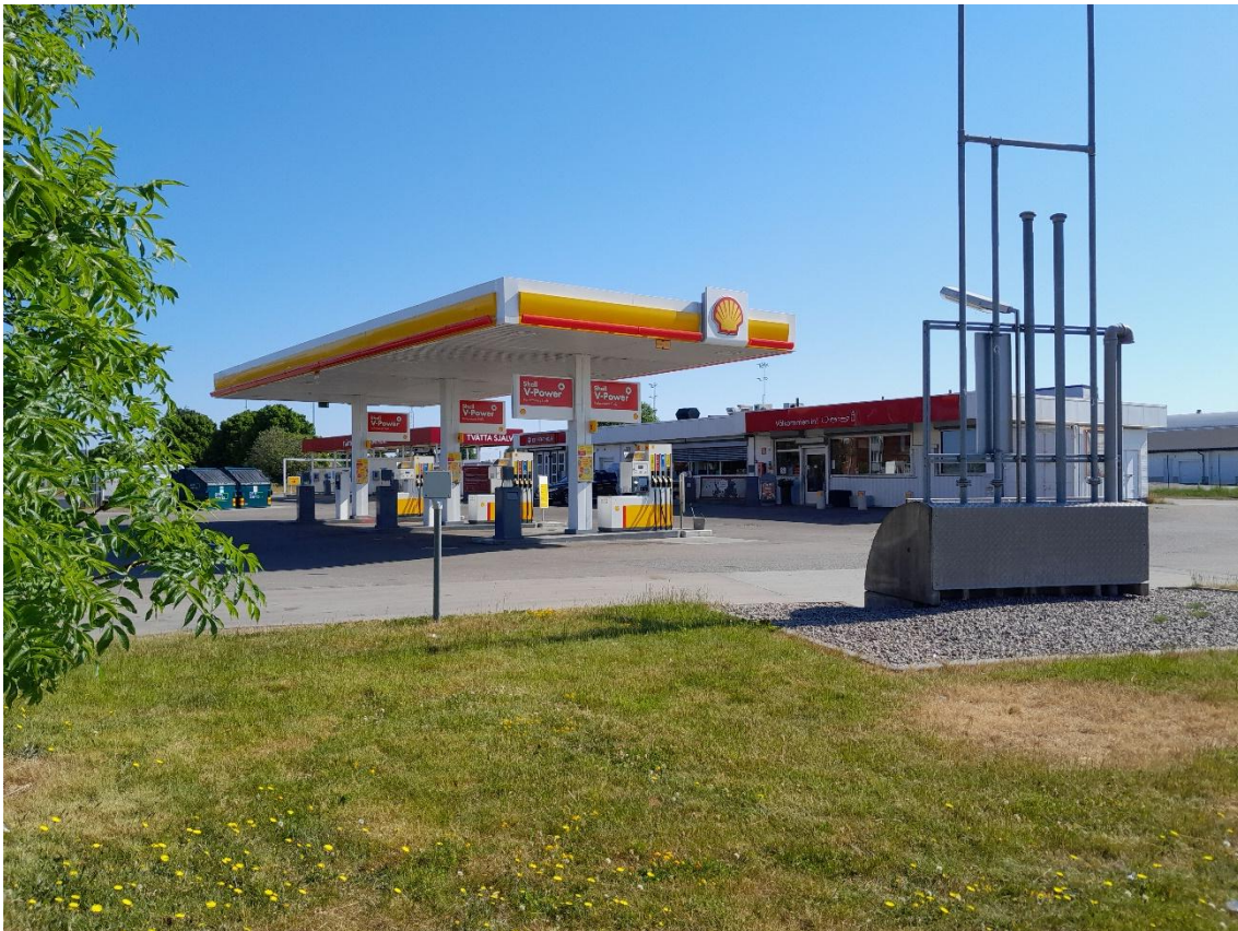
Den befintliga bensinstationen. Källa: Vänersborgs kommun
