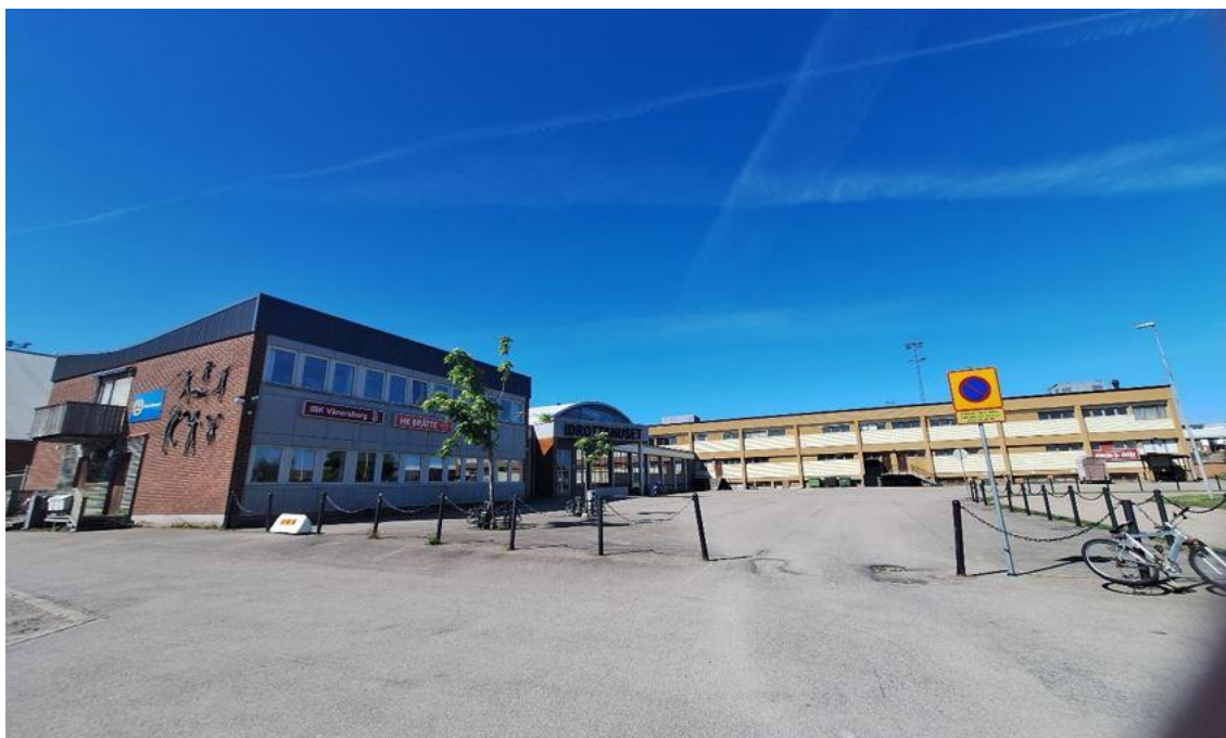
Idrottshuset med tillhörande utbyggnader. Källa: Vänersborgs kommun
