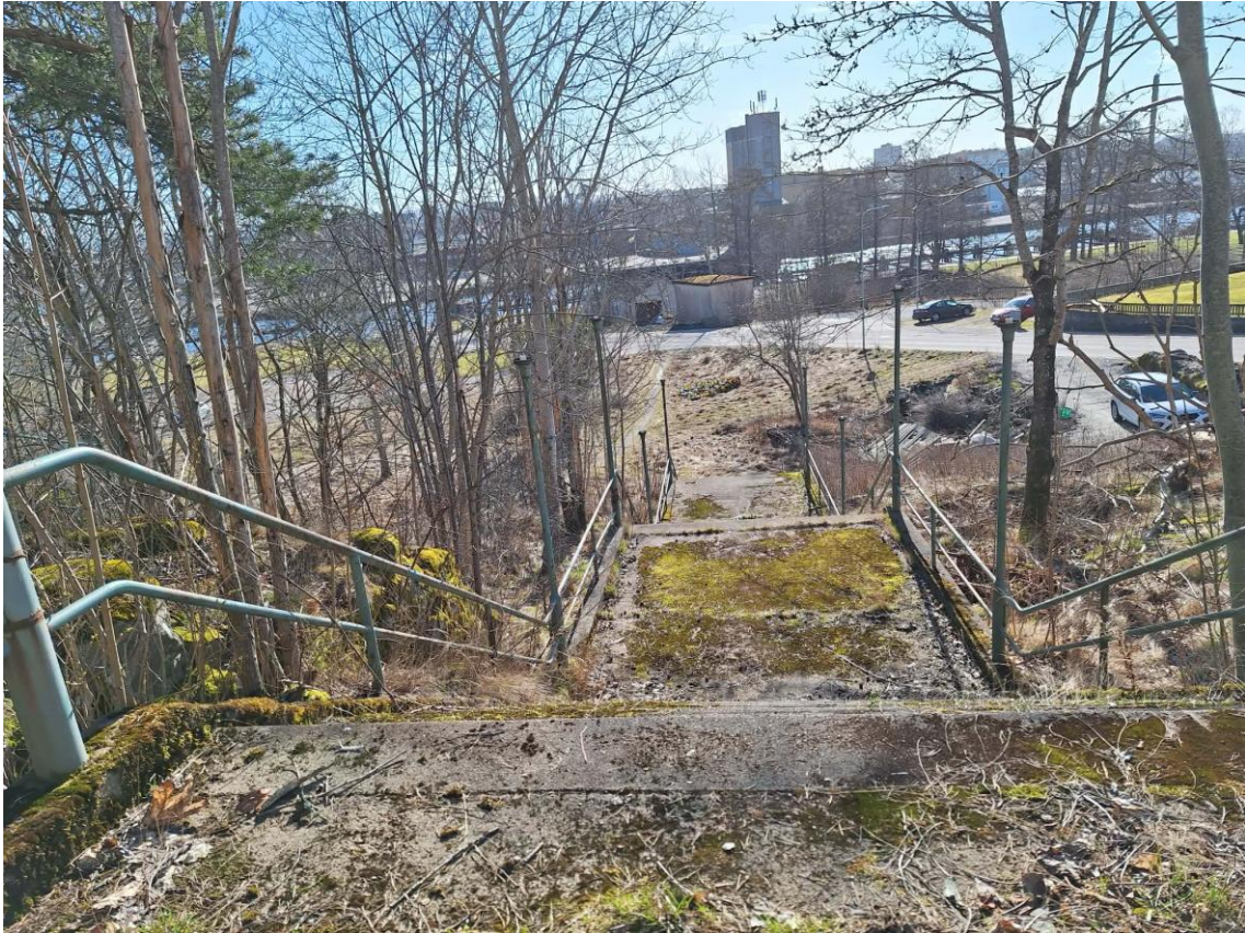
Stentrappan. Källa: Vänersborgs kommun
